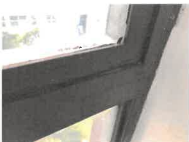
Oceľová zasklená stena – schodisko
