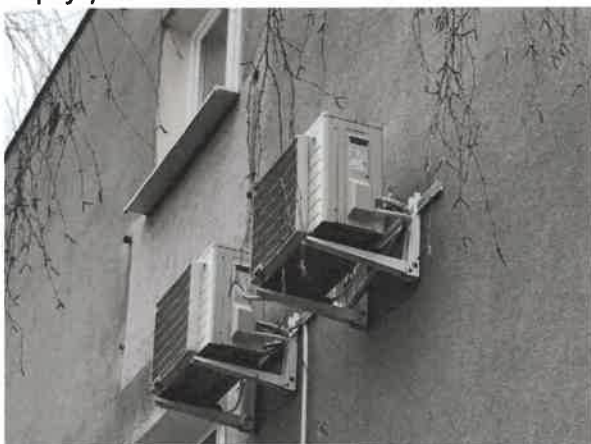
Klimatizačné jednotky na fasáde
